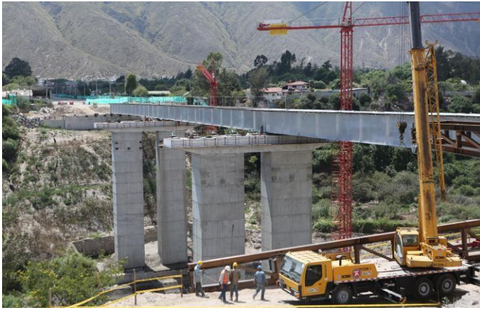
Foto: Construcción puente de Los Pájaros
