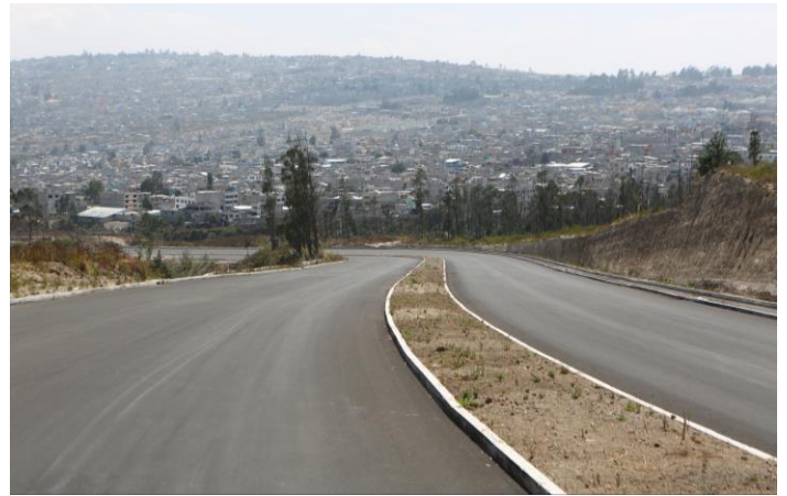
Foto: Prolongación de la Av. Simón Bolívar
