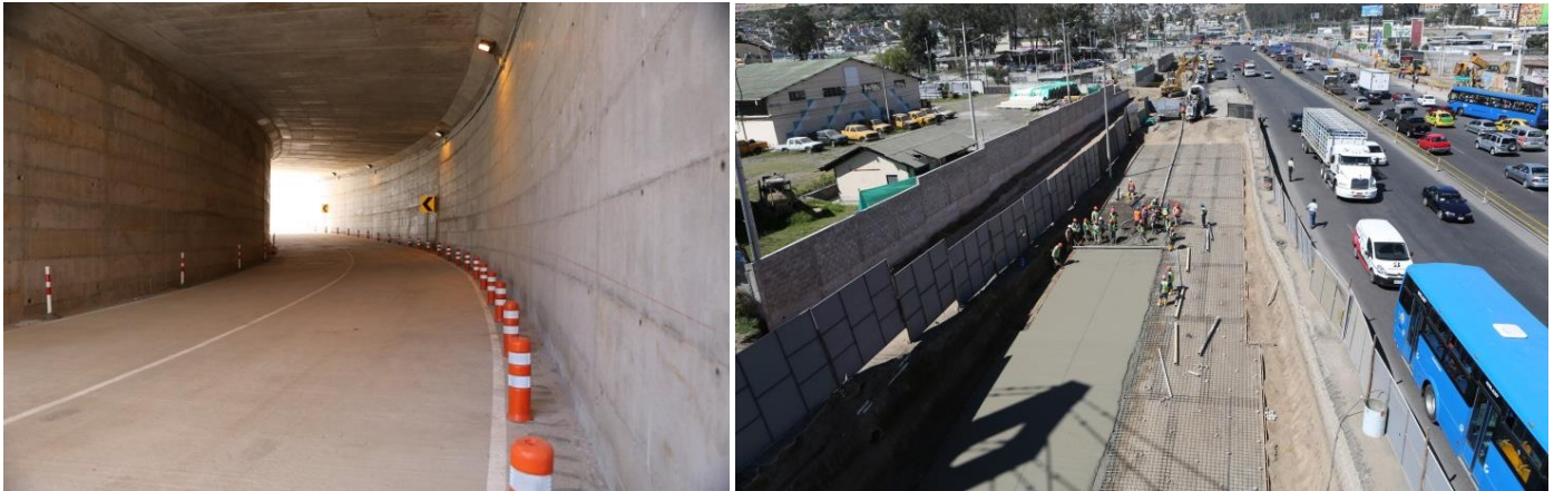
Foto: Construcción Intercambiador Carapungo
