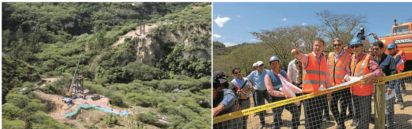
Fotos: Construcción Paso Elevado agua potable
