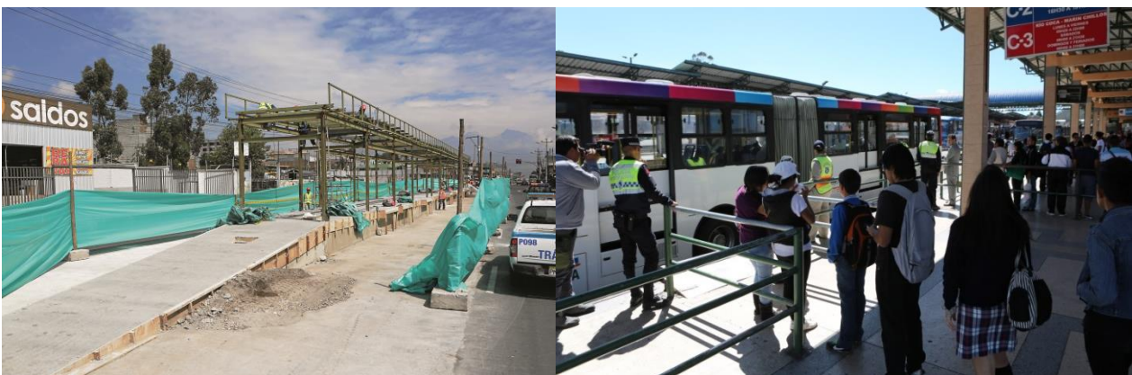
Foto: Construcción Nueva terminal Guamaní
