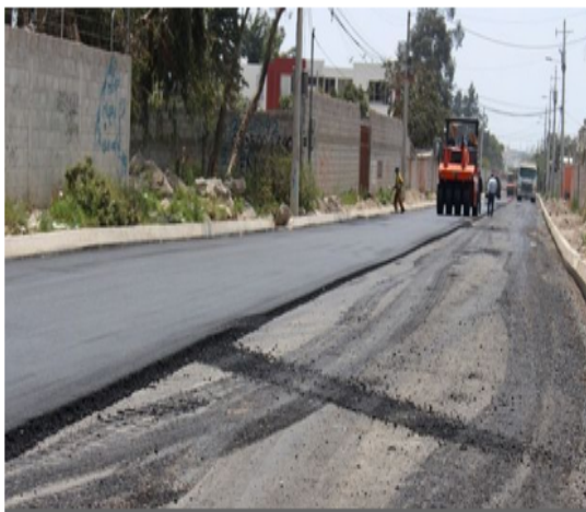
Obra de asfaltado en Calderón
