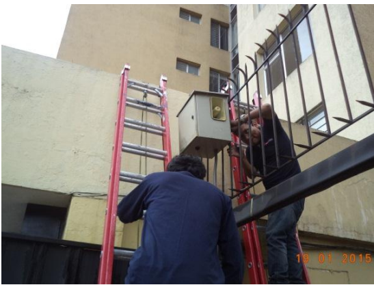
Reinstalación de Sistemas de Alarmas Comunitarias
